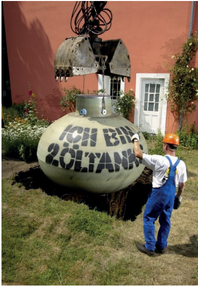
Abbildung 23: Einbau eines unterirdischen GFK-Öltanks (Bildquelle: Haase)
