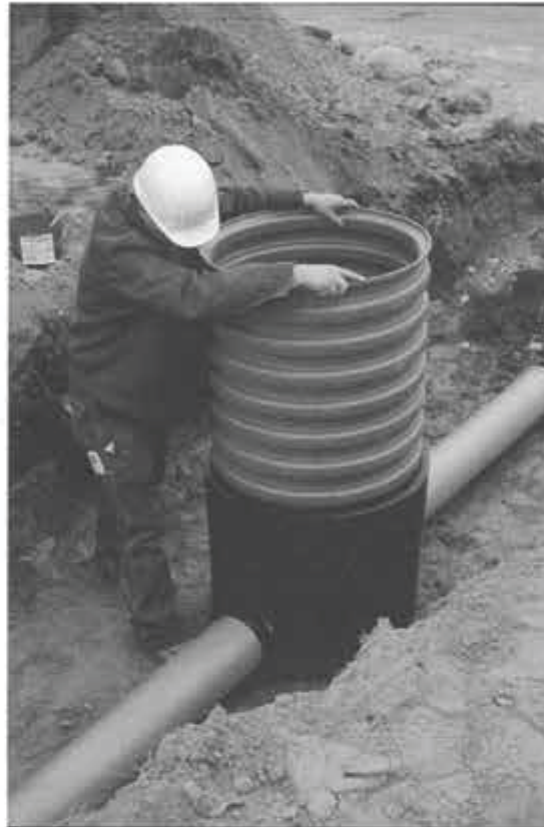
Bild 21 Einbau einer Inspektionsöffnung Werkbild: Wavin, Twist
