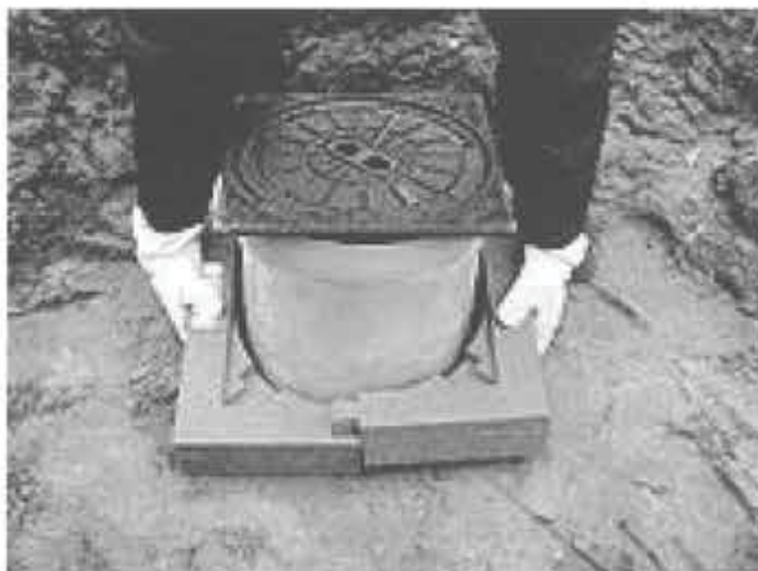
Bild 20 Einbaubeispiel für ein Auflager der Abdeckung eines Inspektionschachtes Werkbilder: REHAU AG + Co, Erlangen
