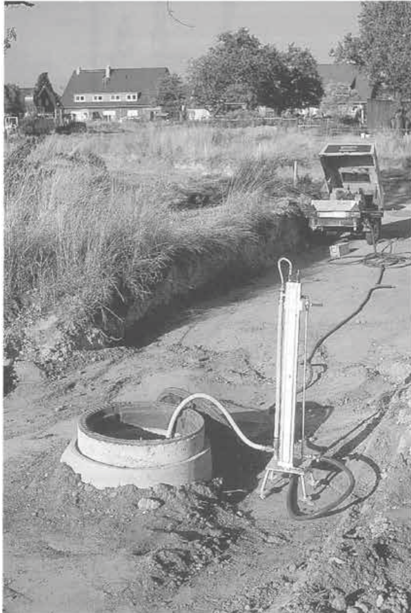
Bild 17 Luftdruckprüfung nach Verfüllung des Rohrgrabens Werkbild: STEINZEUG Abwassersysteme GmbH
