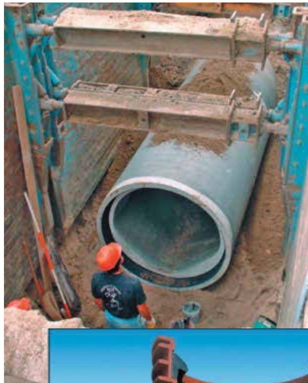
Rohr mit Kreisquerschnitt, ohne Fuß, mit Glockenmuffe und festeingebauter Gleitringdichtung
