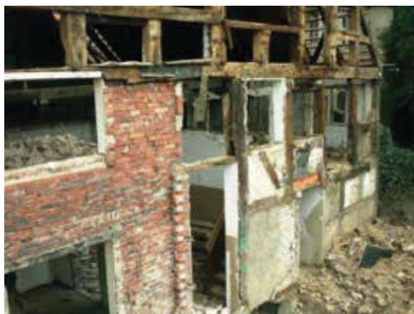
Bild 39 Totalentkernung eines Fachwerkhäuses Foto: C.Bähr
