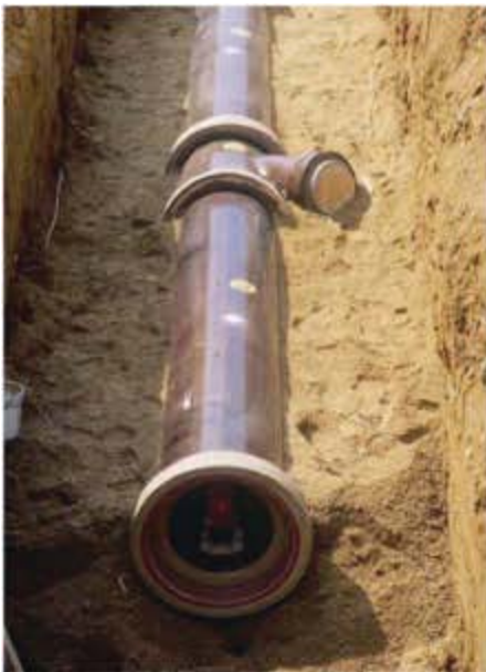
Bild 12 Steinzeugrohr Steckmuffe K Werkbilder: FVST Fachverband Steinzeugindustrie, Köln
