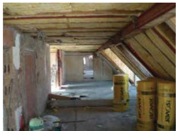
Bild 42 Dachgeschossausbau zur Schaffung zusätzlichen Wohnraumes
