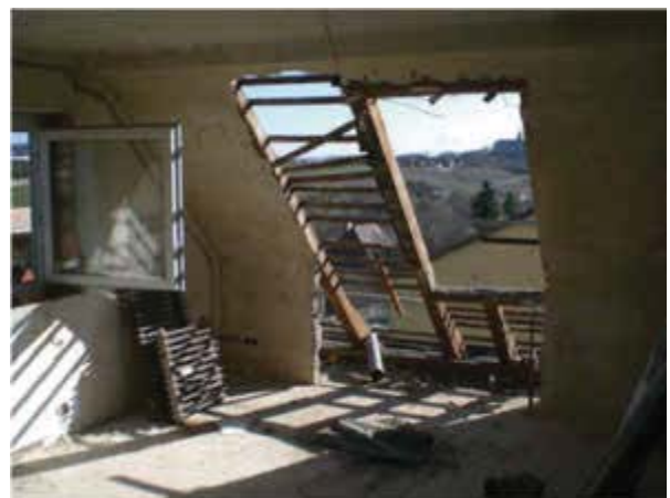
Bild 41 Dachgeschossausbau in Verbindung mit Grundsanierung des Gebäudes
