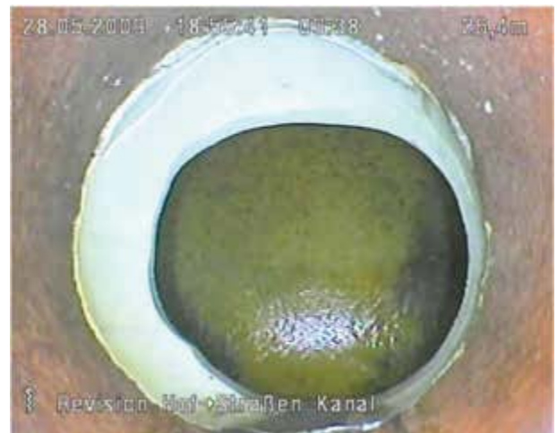
Bild 61 Unvollständig geöffnete Innenauskleidung aus Sicht des Zulaufes
