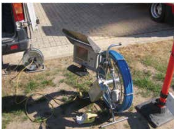
Bild 112 Inspektion der Grundleitung, Monitor und Schiebestangen für die Kamera Foto: Stadtentwässerung Braunschweig GmbH
