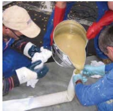
Bild 93 Einfüllen der vermischten Harzkomponenten in den Gewebeschauch
