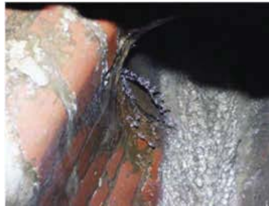
Bild 249 Infiltration DBF D Schadensklasse A
