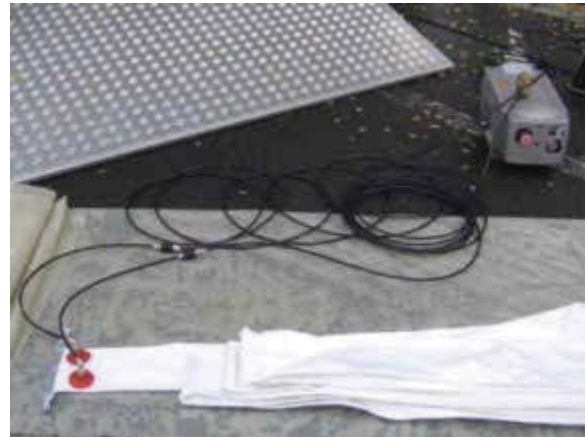
Bild 92 Herstellung eines Vakuums für die Schlauchimpregnierung, das bis zur Verteilung des Harzes aufrecht erhalten bleibt
