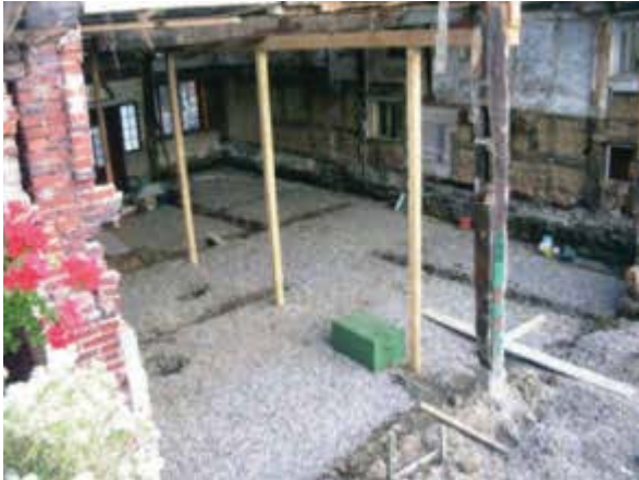
Bild 40 Totalkernung und Sanierung der Gebäudesubstanz. In diesen Fällen sind die Entwässerungsanlagen neu zu planen und entsprechend DIN 1986-100 herzustellen.
