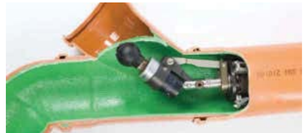
Bild 79 Abzweig wird ausgefräst Werkbild: Fa.: BRAWOLINER®, Karl Otto Braun GmbH & Co. KG, www.brawoliner.de
