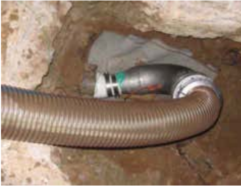
Bild 95 Inversion des Schlauches mit Druckschlauch in das offene Ende einer Steinzeugrohrgrundleitung
