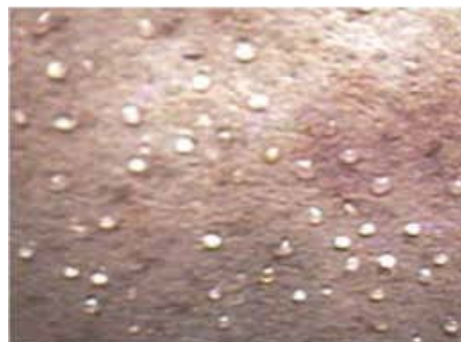
Bild 178 Kondenswasser, BBF A (keine Infiltration), Schadensklasse C
