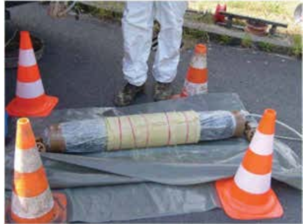
Bild 75 Packer für Kurzlinereinbau
