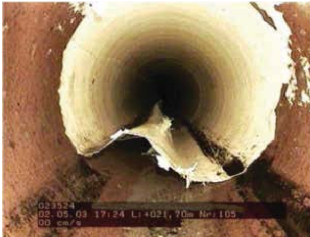
Bild 59 Abgelöster Kurzschlauch
