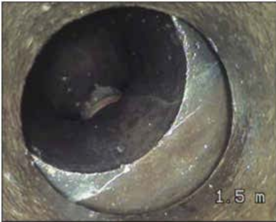
Bild 56 Radiale Lageabweichung
