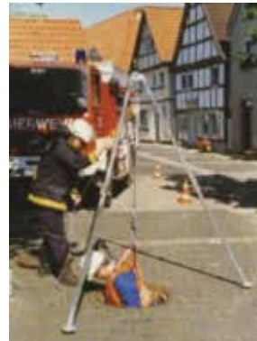
Bild 149 Dreibock zum Abseilen von Personal in den Abwasserkanal oder eine Abwassersammelgrube/ Kleinkläranlage Werkbild: links: MÜLLER Umwelttechnik GmbH & Co. KG rechts: Härke GmbH & Co. KG
