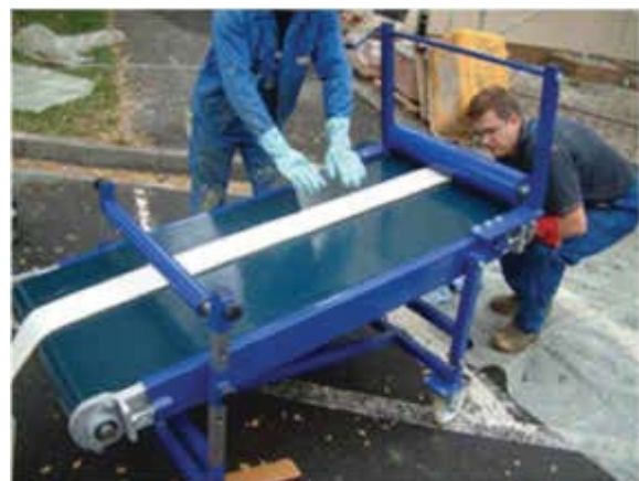
Bild 94 Einbringen und Verteilen des Harzes im Gewebeschauch auf einem Imprägniertisch durch Einwalzen
