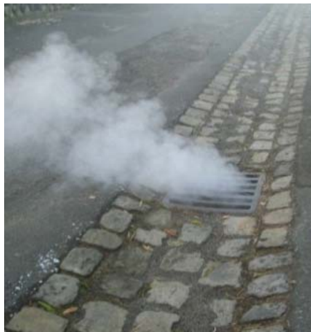
Bilder 179 und 180 Überprüfung auf Fehlanschluss durch Benebelung Foto: Stadtentwässerung Braunschweig GmbH
