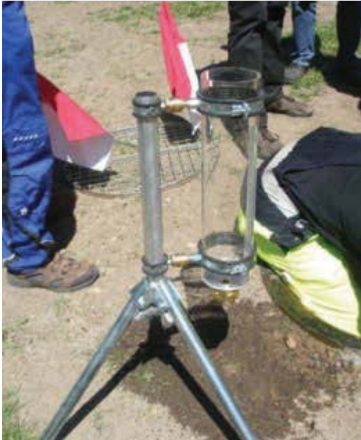
Bild 139 Befüllzylinder für eine Wasserdruckprüfung über den mit einem angeschlossenen Schlauch der Prüfdruck aufrechterhalten wird. Der Drucksensor ist an die Prüfblase im Schacht (Bild 141) angeschlossen. Im Hintergrund ein Sicherheits-Schachtabdeckrost. Foto: Stadtentwässerung Braunschweig GmbH
