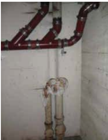
Bild 68 Außerbetriebnahme der Grundleitungen, stattdessen Sammelleitungen Die alten Fallleitungen werden noch fachgerecht verschlossen. Foto: Franz Fischer Ingenieurbüro GmbH, Erfstadt
