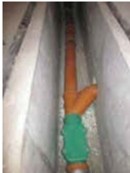
Bild 100 Zugängliche Verlegung im Rohrkanal
