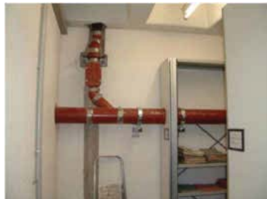
Bild 70 Außerbetriebnahme der Grundleitung durch Einbau einer Sammelleitung im Keller einer Behörde in Würzburg
