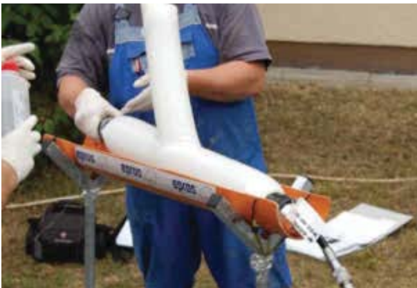
Bild 83 Packer für die Sanierung von Anschlussstutzen in Grundleitungen mit Hutprofiltechnik Fa. Trelleborg Pipe Seals Duisburg GmbH www.trelleborg.com
